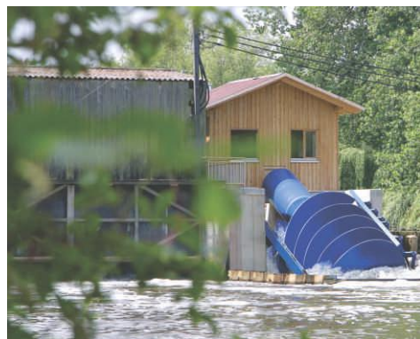
48.1 KW System, Baiersdorf
